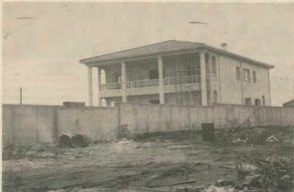
Λάθος, δεν είναι ένα κτίριο του Πανεπιστημίου (μη σας συγχίζουσι κολώνες) Είναι το καινούργιο σπίτι του κ. Ρολάνδη
